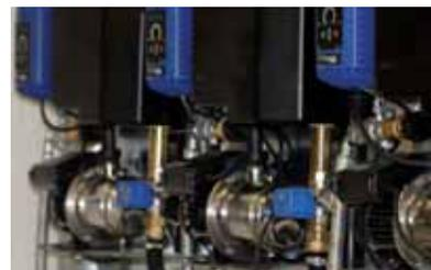
Ein RAINMASTER Favorit SC verursacht nur 45 dBA bei der Befüllung eines WC's im Vergleich zu 75 dBA bei einem unregelmäßigem Regenwasserwerk.
