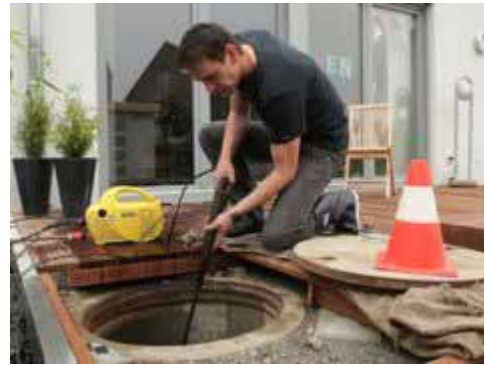
Abb. 15: Reiniging van het zeefvlak met een hogedrukreiniger
