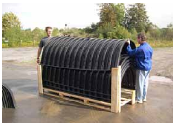
Afb. 6: Opheffen van de tunnelementen
