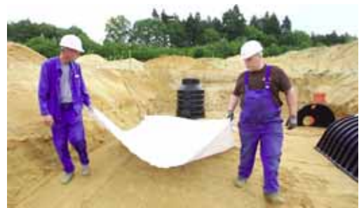
Afb. 28: Geotextiel op de bodem
