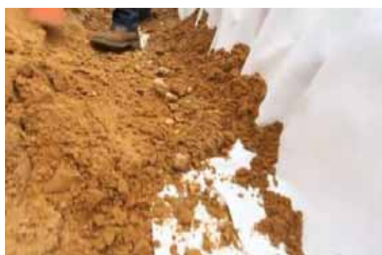
Afb. 32: Anaarden van het geotextiel voor fixering
