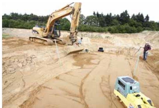
Afb. 34: afdekking van de tunnelementen
