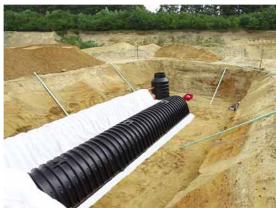
Afb. 31: Afdekking met geotextiel
