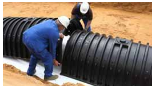
Afb. 30: Vormgesloten verbinding van twee tunnelementen door overlapping
