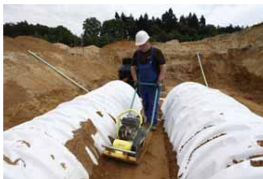
Afb. 33: Verdichten met klein verdichtingsstoestel tussen de tunnelrijen
